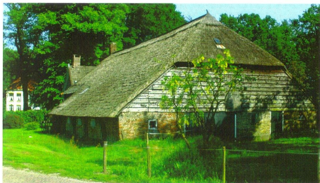
34) Het boerderijgedeelte vanaf de Postweg gezien. Links het pand waarin Tea Time is gevestigd
